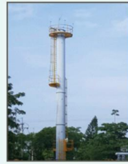
• 中油天然氣燃燒塔 •
